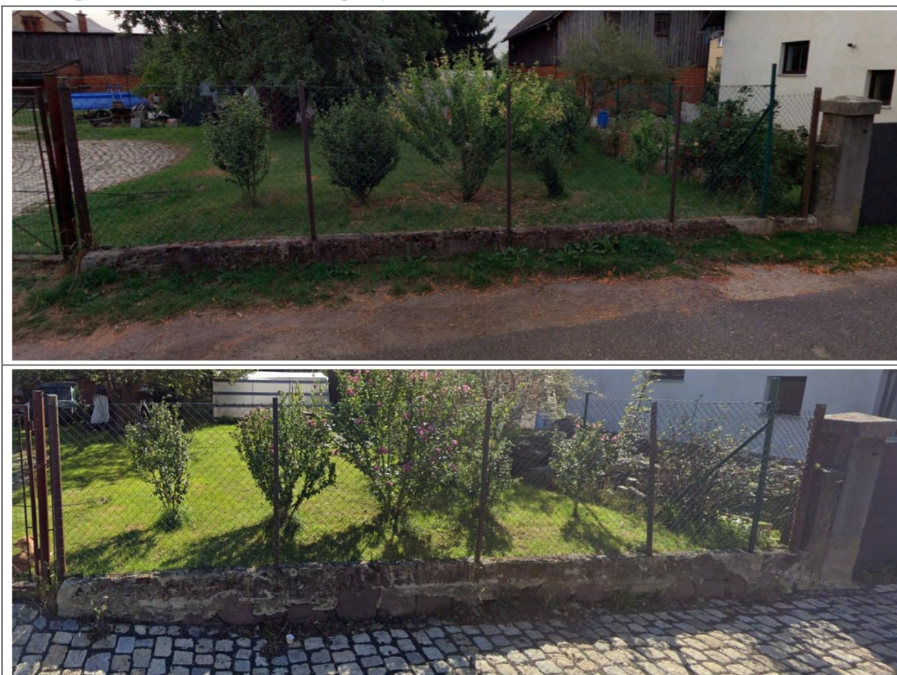
Obr. 13. Přímé porovnání výšky podezdívky oplocení na základě fotografií. Vlevo snímek z aplikace mapy.com z roku 2022 (před opravou). Vpravo snímek z google.com z roku 2024 (po opravě).
