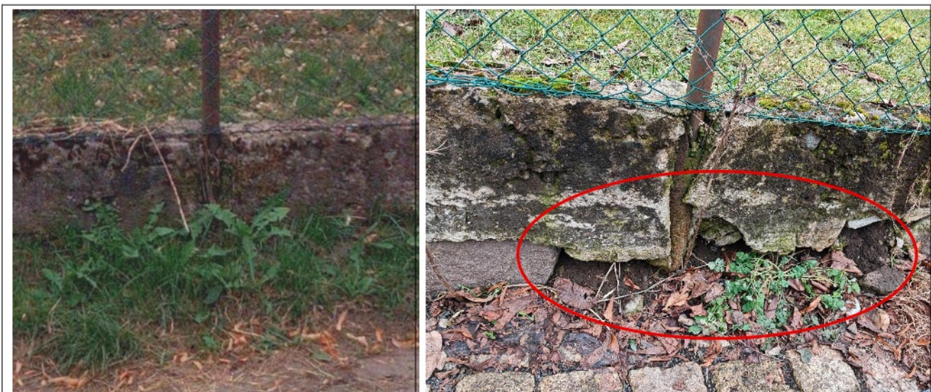
Obr. 12. Přímé porovnání hloubky založení oplocení na základě fotografií. Vlevo archivní snímek z aplikace mapy.com z roku 2022. Vpravo aktuální snímek pořízený během místního šetření z roku 2026. Na snímku vpravo je patrná odhalená zemina pod základem oplocení.
