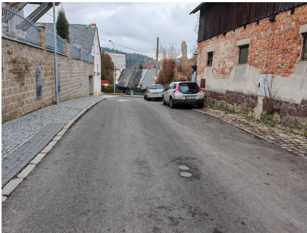
Obr. 1. Pohled severním směrem do ulice J. A. Komenského, v dále se komunikace napojuje na ul. Liberecká. Podél pozemku p.č. 903 a 904 je vozovka vyspádována jednostranně – směrem k těmto pozemkům, jak je vidět i prostým okem.
