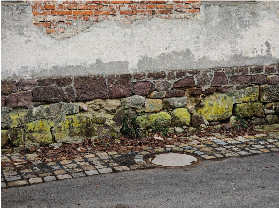
Obr. 11. Pohled na revizní otvor kanalizační šachty.
