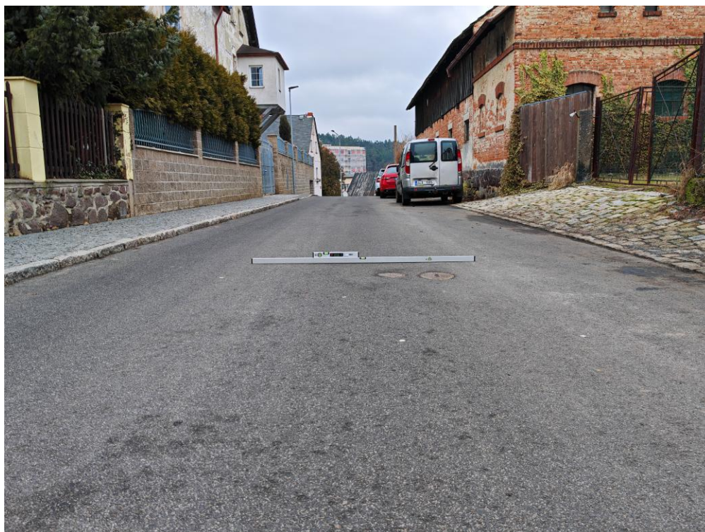
Obr. 2. Pohled na část komunikace navazující na nájezd do dvora pozemku p.č. 903. Sklon vozovky byl měřen za pomoci dvoumetrové latě a digitálního sklonoměru.
