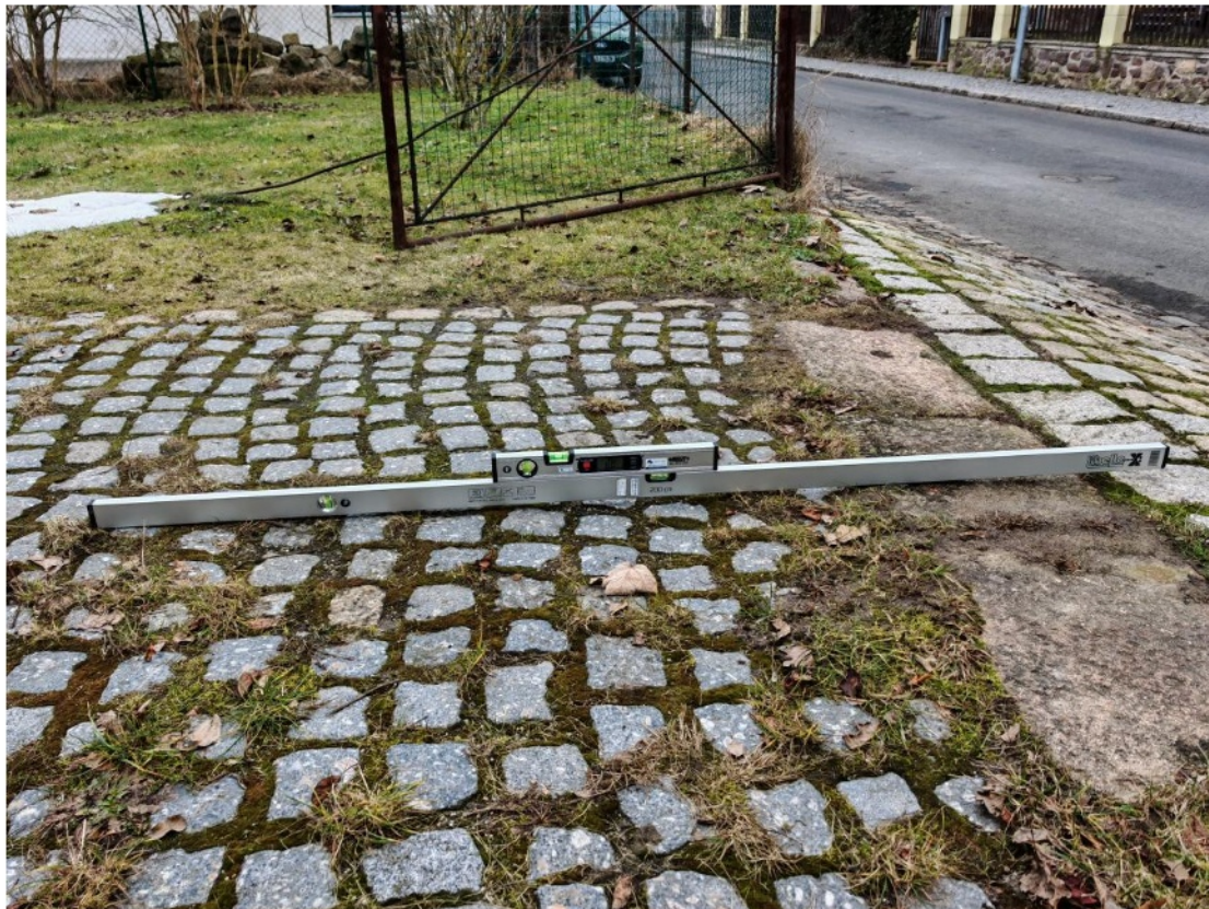
Obr. 6. Dlážděná plocha ve dvoře na pozemku p.č. 903 je rovinná, beze sklonu.
